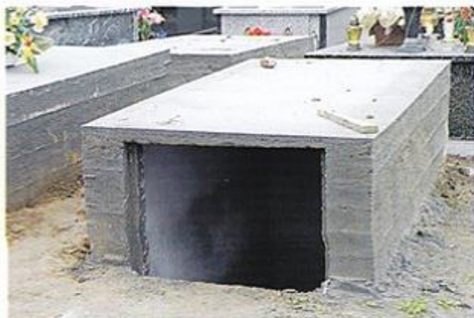
Budowa pieczary grobowcowej.
